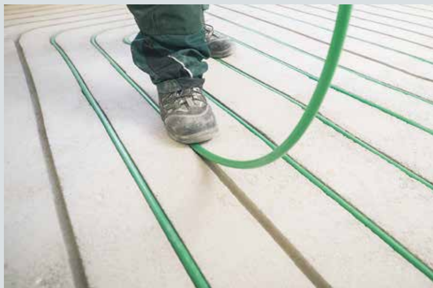
Nachdem die Kanäle in den Estrich eingefräst sind, werden die „Klimapex“-Rohre verlegt.
