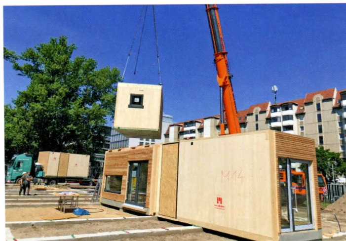
Der Kindergarten besteht aus 16 Modulen, die innerhalb von 10 Wochen hergestellt wurden.
