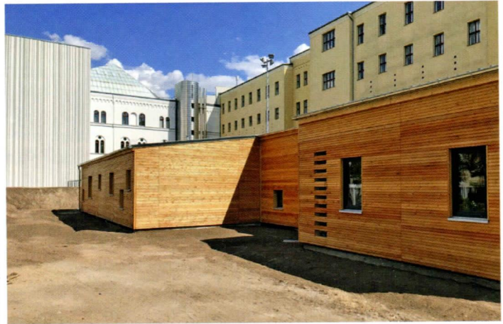
Die Luftwärmepumpe befindet sich außerhalb des Gebäudes und ist dennoch von der Fassade umschlossen. Ihren Standort erkennt man an den Lüftungsschlitzen in der Fassade.
